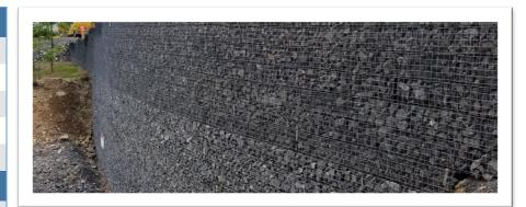
Le système Novamur est un mur mécaniquement renforcé composé d'un treillis métallique de façade retenus par des inclusions de géogrilles à l'intérieur d'un remblai contrôlé. L'unité de façade retient la pierre ou la terre selon la finition désirée (pierre ou végétalisé). Il s'agit d'un système modulaire qui s'adaptera à la topographie du terrain à stabiliser.
