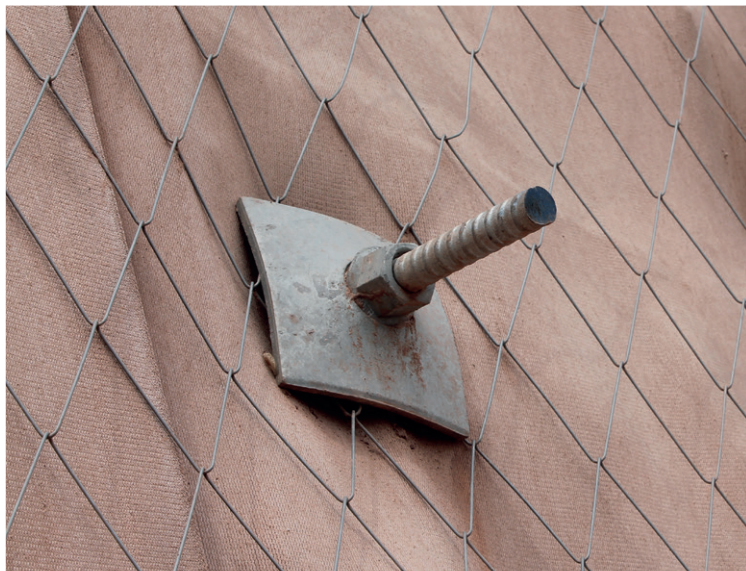
Boulon d'ancrage et grande plaque d'ancrage avec coins arrondis
