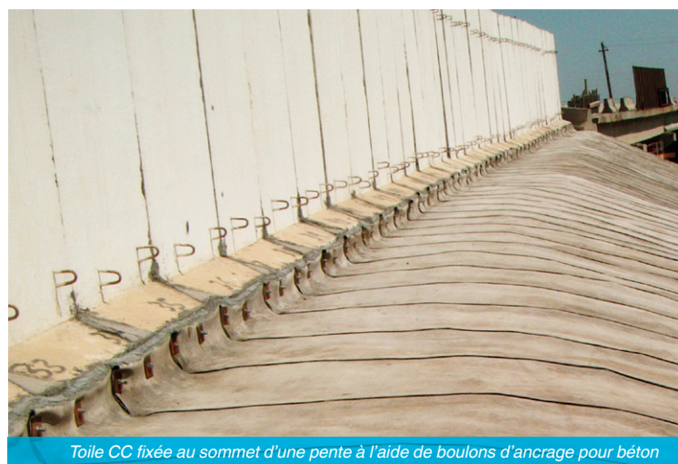
Schéma de fixation type à un mur amont en béton au moyen de pointes de type « Hilti »
