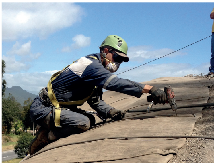
Jointure de couches adjacentes de toile CC à l'aide de vis en acier inoxydable
