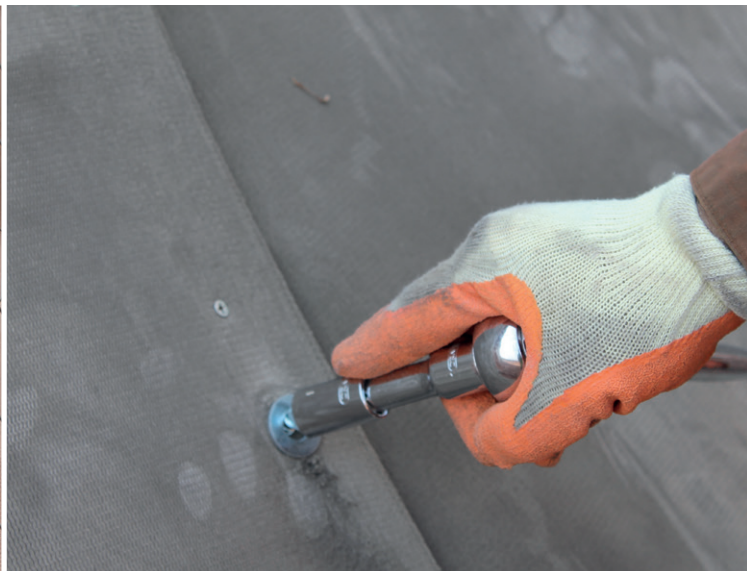
Toile CC fixée à la pente à l'aide d'un boulon d'ancrage
