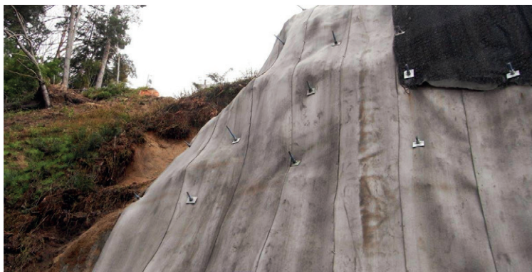
Projet de stabilisation et de protection de pentes en toile CC, Karapiro Gully, Nouvelle-Zélande
