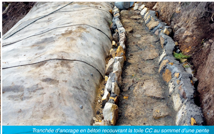
Toile CC fixée au sommet d'une pente avec pieux et tranchée d'ancrage
