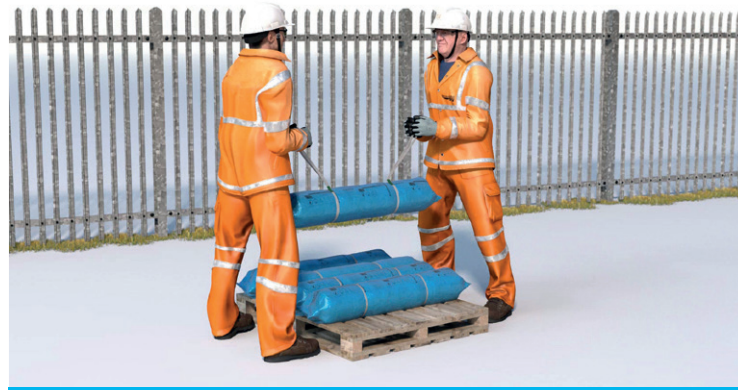
Levage manuel de petits rouleaux de toile CC
