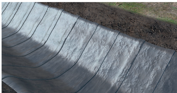
Remblayez la tranchée d'ancrage
