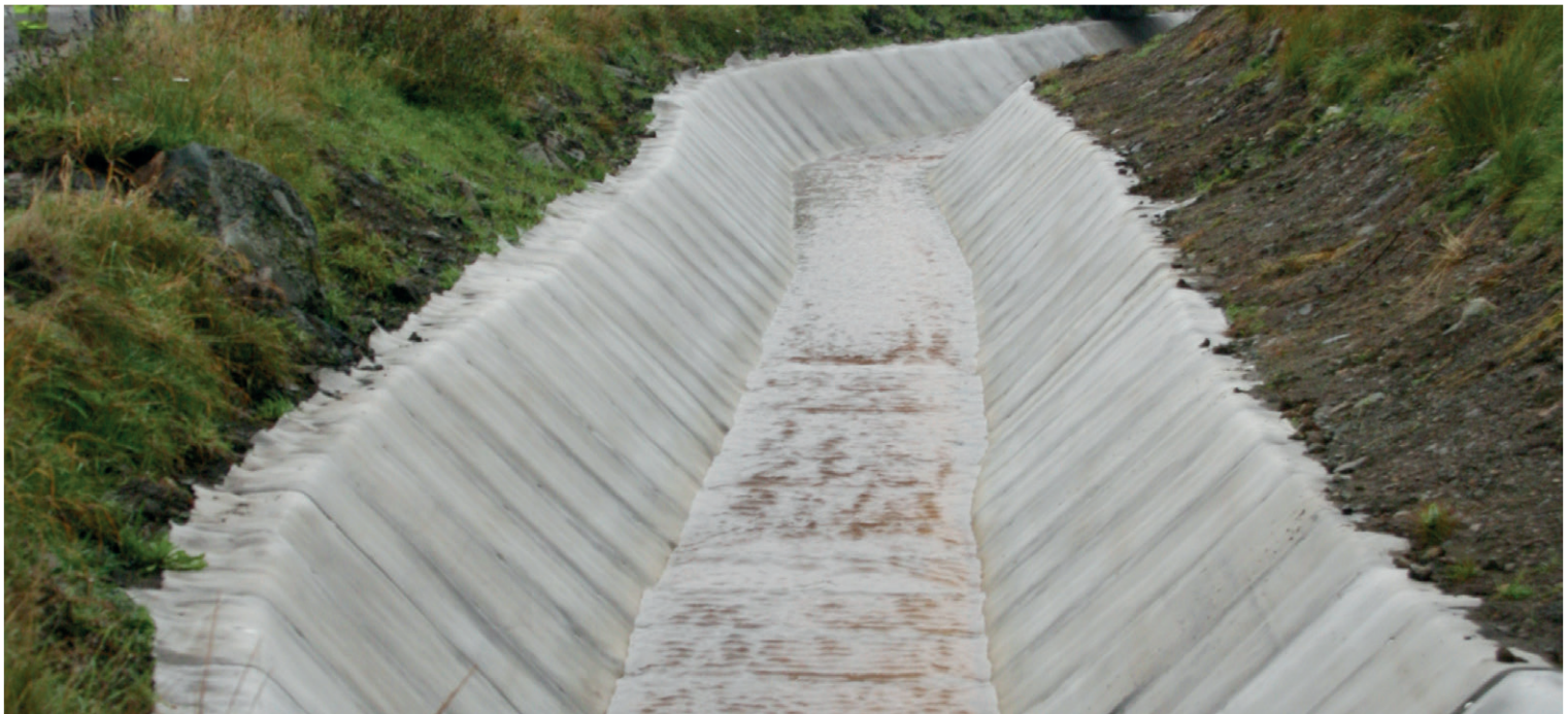
Revêtement de canaux à l'aide de toile CC - Remise en état, Bowburn, Écosse, Royaume-Uni
