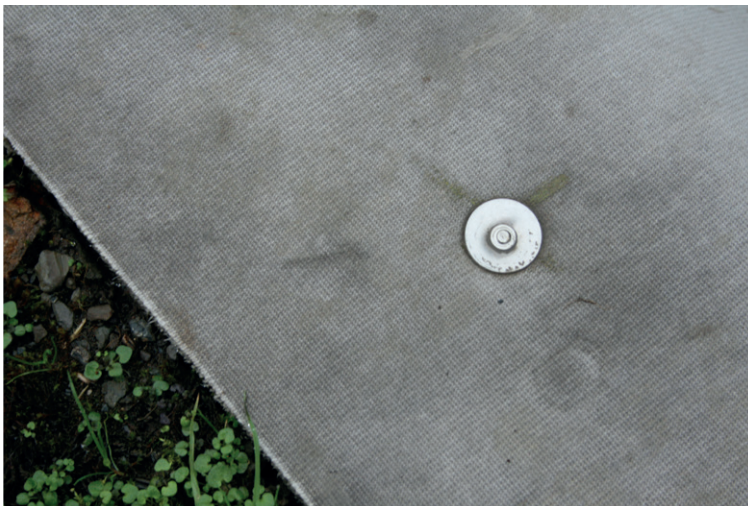
Toile CC ancrée à l'aide de pointes pour béton introduites au pistolet avec rondelles de 20 mm
