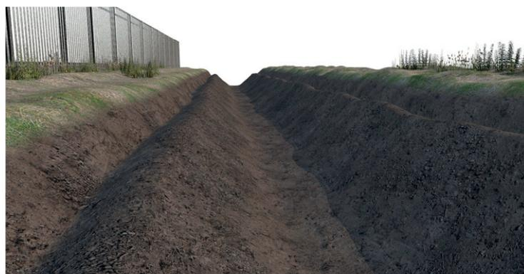
Préparation du support et tranchée d'ancrage
