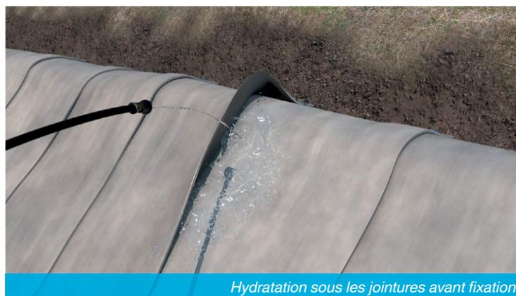
Hydratation sous les jointures avant fixation
