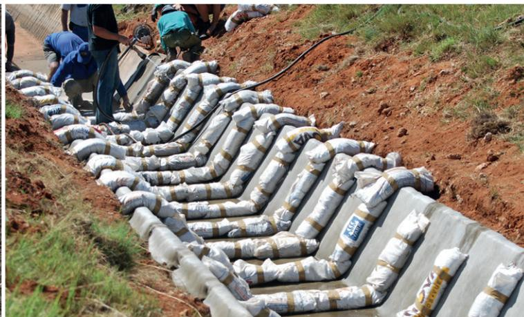
Des sacs de sable peuvent être utilisés pour comprimer les jointures pendant la prise.
