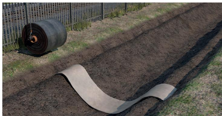
Toile CC placée dans une tranchée d'ancrage avant découpe
