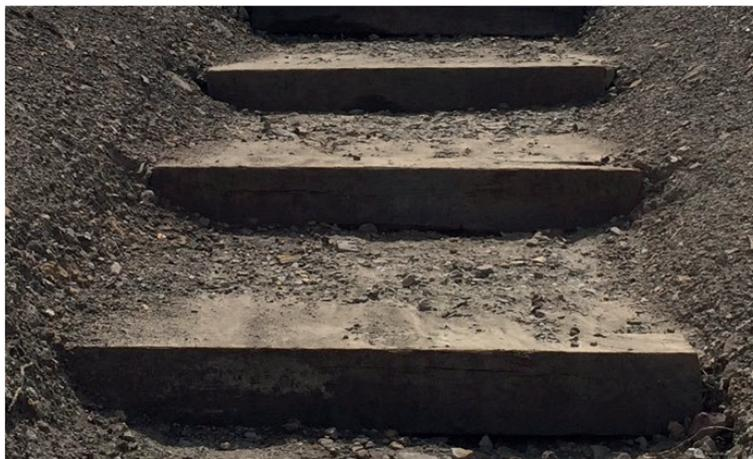
Des chicanes peuvent être formées en posant la toile CC sur des structures en bois fabriquées ou des sacs de sable.
