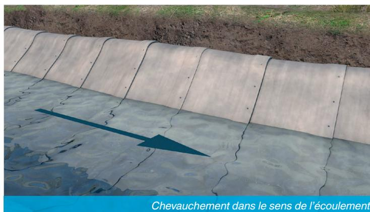
Chevauchement dans le sens de l'écoulement
