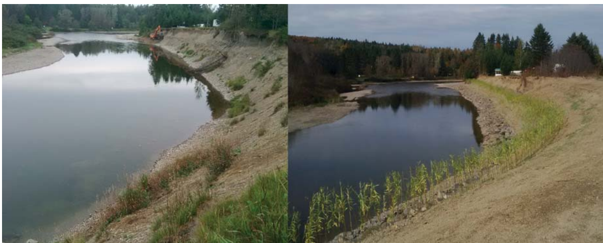
Zone à stabiliser, avant/après.
