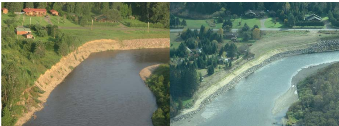
Zone à stabiliser, avant/après.
