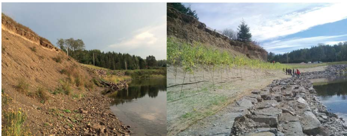
Zone à stabiliser, avant/après.
