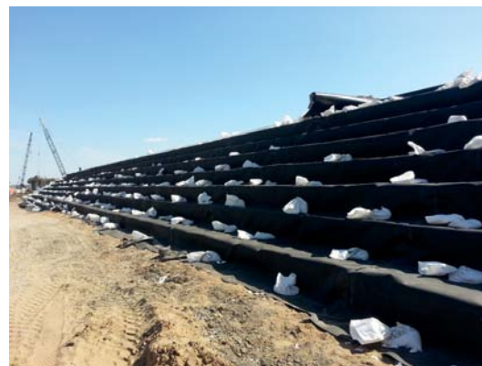
Remblai léger imperméabilisé avec PEHD 40mils texturé noir.
