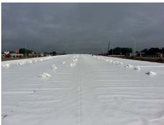
Remblai léger imperméabilisé avec PEHD 40mils texturé blanc.
