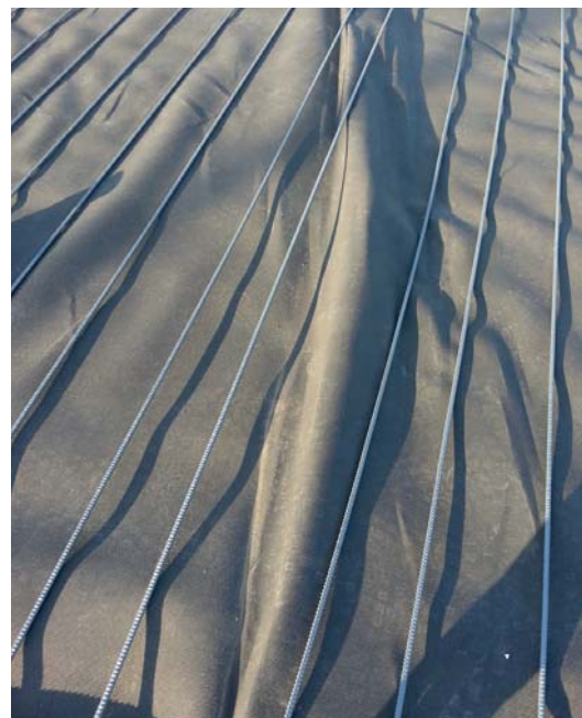
Ondulations dans la géomembrane sous l'armature du béton.
